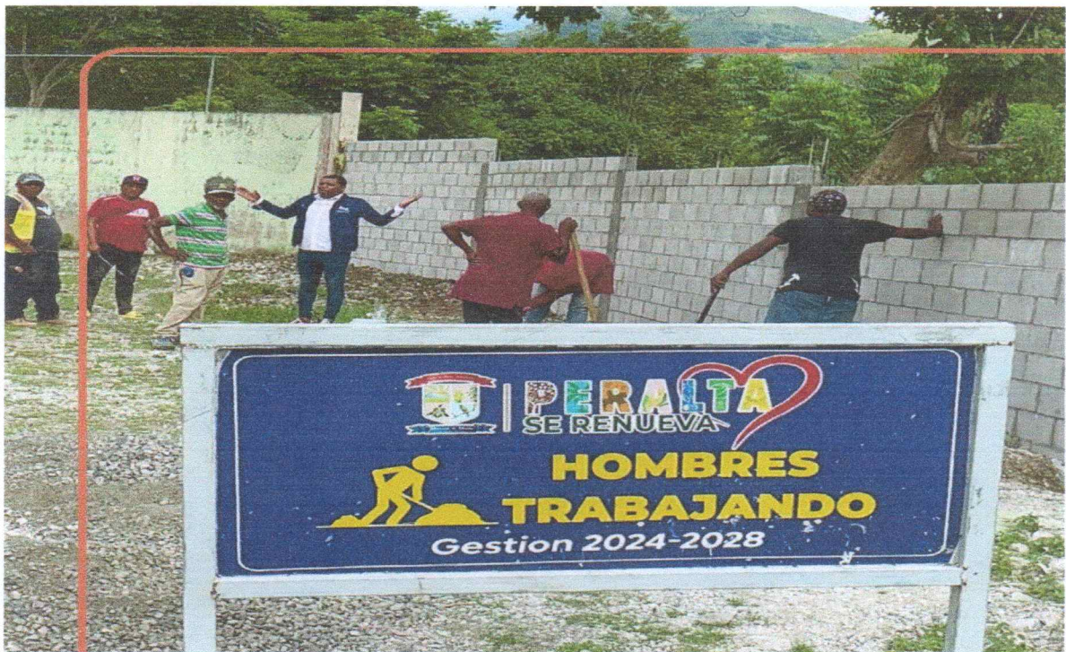
Avances de las reparaciones del play municipal.
